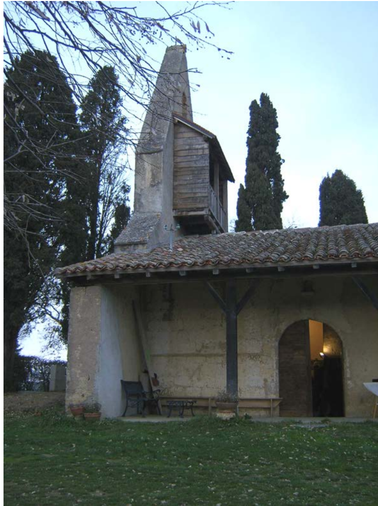
Clocher et plafond de la chapelle de Saint-Pé d'Arès (photos Renée Courtiade)
