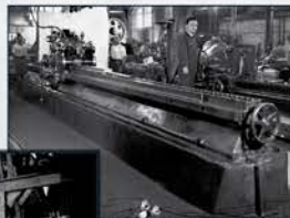
Chaine à l'ingénieur, machine aux opérations de finition par Dewoitine pour l'usage des avions à tir de D.520. On mesure 10 mètres de long et jante 18 centimètres. 82 P, 101 102
